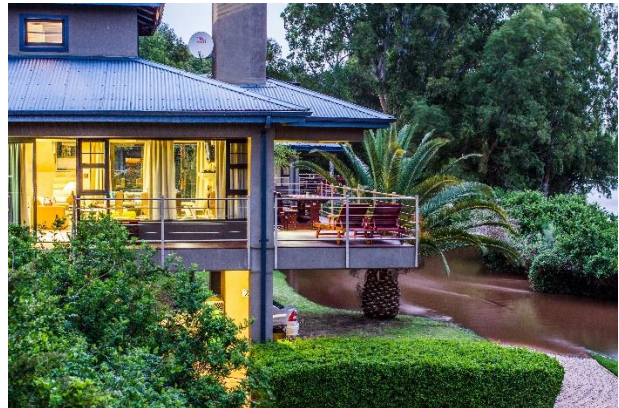
Die water is nou al oor die pad
